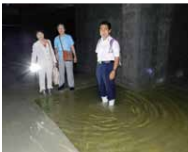
豊洲新市場の地下を調査するとくとめ都議。
